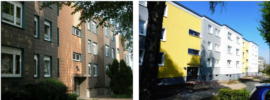
Spar- und Bauverein eG, Osningstraße 16 a und b, in den Jahren 2013 und 2018 Quelle: Stadt Dortmund, Amt für Wohnen und Stadterneuerung
