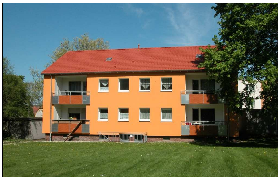
gws-Wohnungen Unterdelle 20, Gebäuderückseite; Foto: Stadt Dortmund, Amt für Wohnungswesen, 2014
