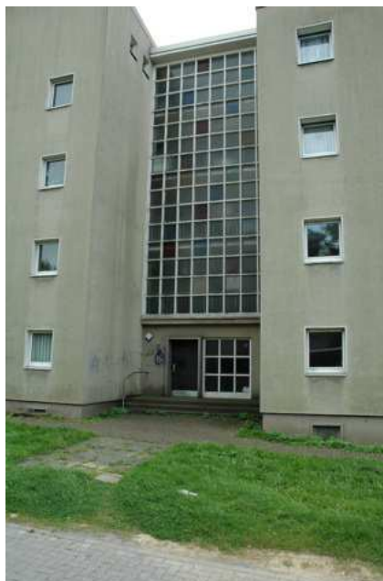
Punkthochhaus Gesenhofstraße Quelle: Eigenes Bild
