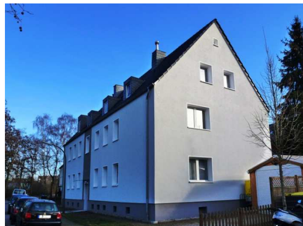
Foto: G. Schmidt-Goslowski Mit Fassadendämmung
