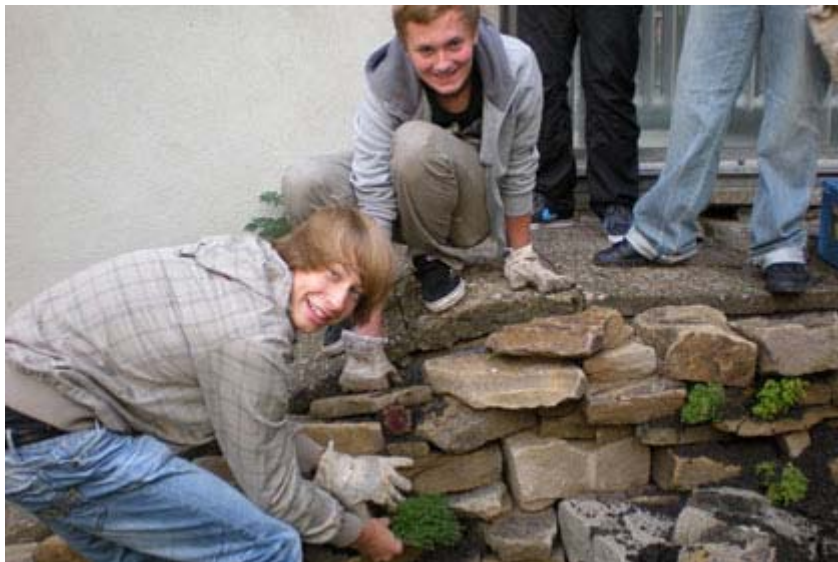
Aufbau der Trockenmauer am Gartenteich und Ausgestaltung mit Pflanzen
