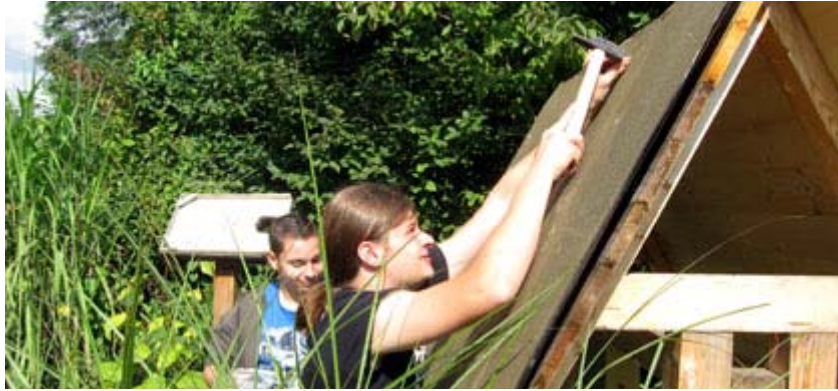
Dacharbeiten am Insektenhotel
