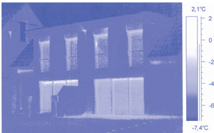
thermographische Abbildung eines wärmebrückenarmen Gebäudes
